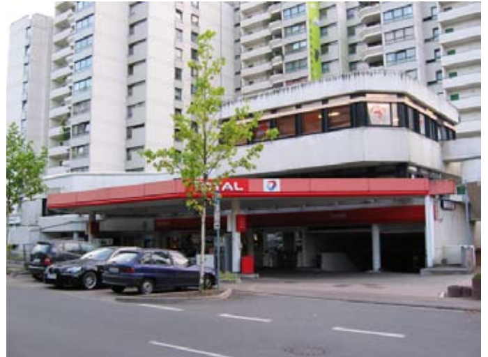
Fasenerie-Zentrum: Einfahrt Tankstelle
